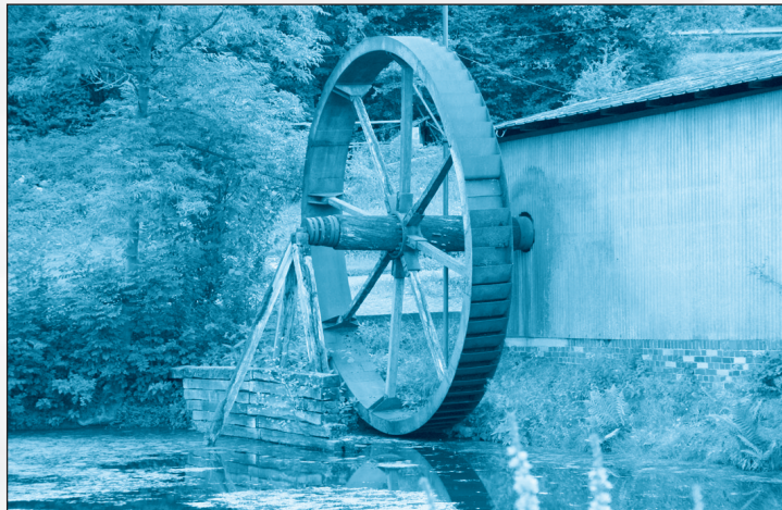
Das riesige Mühlrad wurde mit Wasser von einem oberhalb gelegenen Bach über eine Holzkonstruktion angetrieben.
